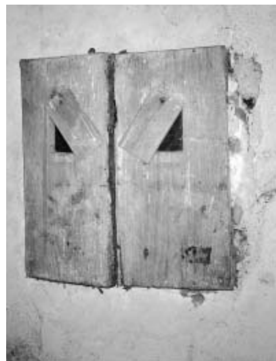
Une ruche-placard fermée vue de l'intérieur de l'habitation
